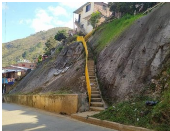
IMAGEN 30 Obras de mitigación en límites entre Llanaditas y Golondrinas, vía hacia El Faro Archivo comunitario
