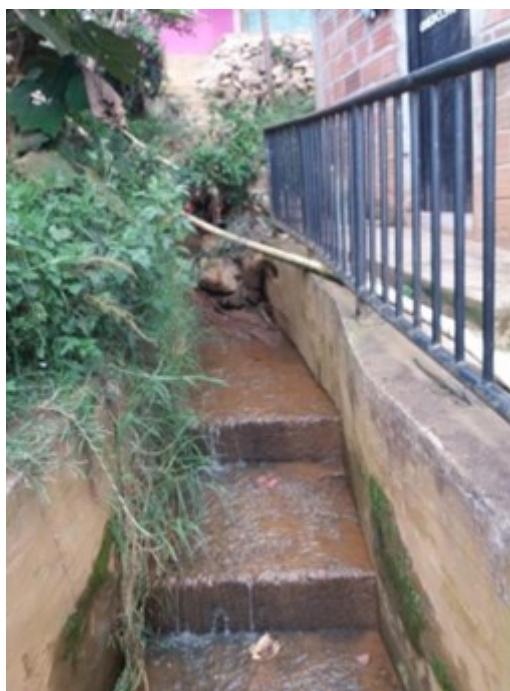
IMAGEN 12 Canalización de quebrada Chorro en paso peatonal Altos de la Torre Archivo comunitario
