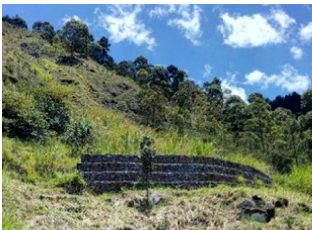
IMAGEN 29 Gaviones para controlar caída de rocas. Obras de mitigación en ladera Archivo comunitario
