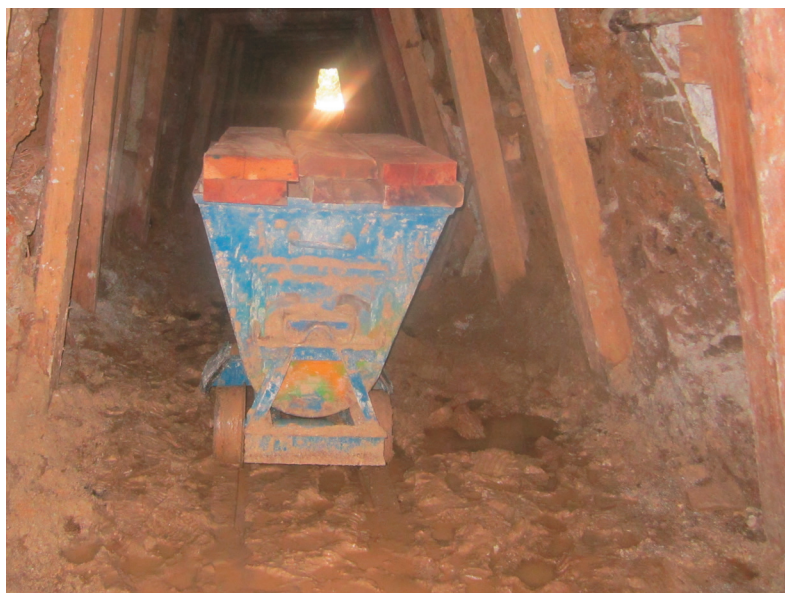
Fotografía: José F. Valencia G. socavón
